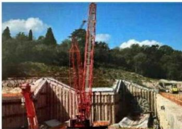
Cantiere Icm è specializzata in costruzioni e grandi opere
